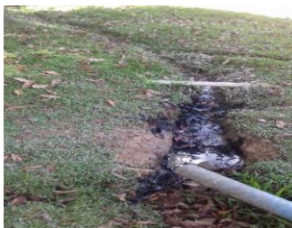
Figura 3 – Rede de Esgoto na Comunidade Indígena Bananal
