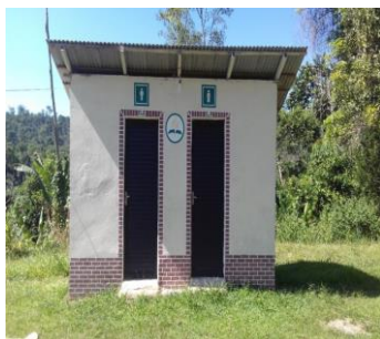
Figura 6 – Fossas Sépticas e Situação dos Sanitários da Comunidade Indígena Bananal
