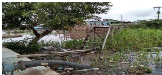
Figura 02 - Dejetos de esgoto despejados diretamente nas valas, Município de Atalaia do Norte.
