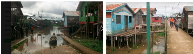
Figura 07 e 08 - Dejetos de esgoto despejados diretamente na rua, Município de Atalaia do Norte.
