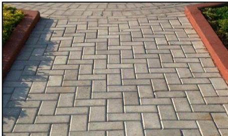
Figura 07 – Piso Intertravado Pré-moldado. Fonte: VOLF Pré-moldados
